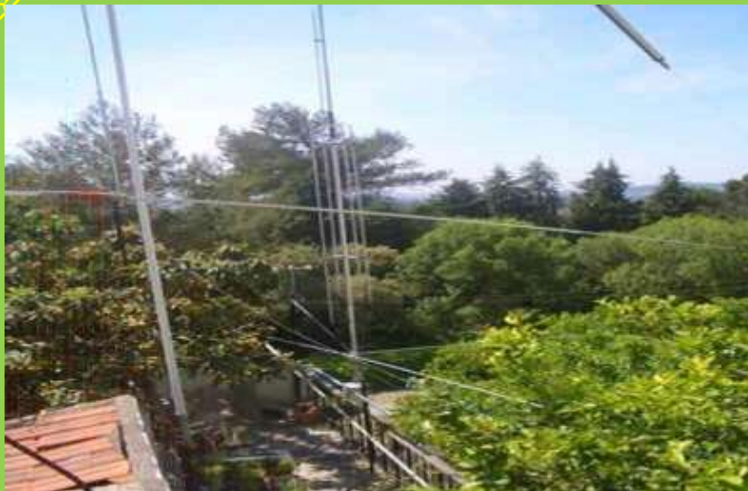
Ilustração 19 - Antenas : Titan Eagle HF , antena VHF vertical colinear 7x1/2 ondas, antena 5/8 para 10 mts. e uma 2 BDQ 40 e 80 mts.
