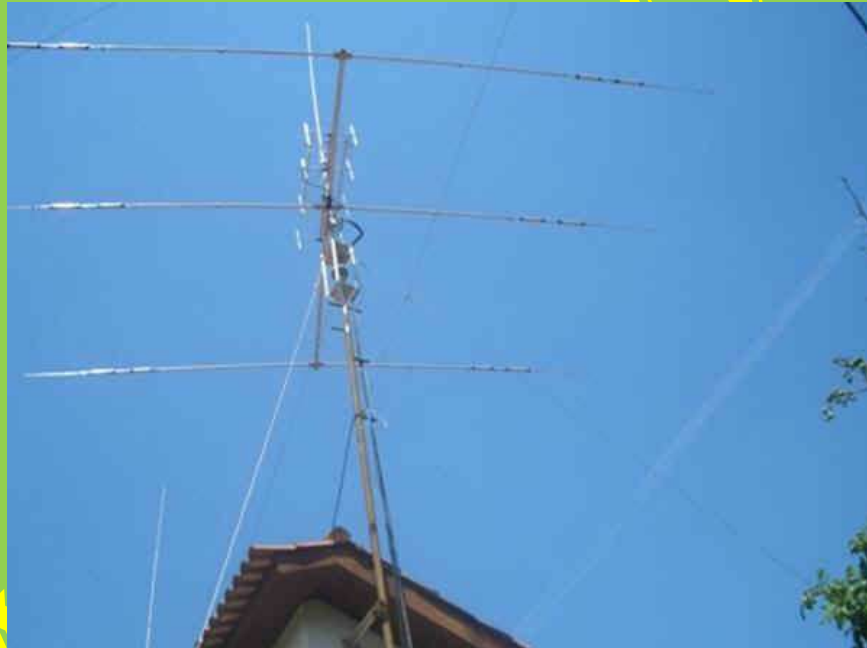
Ilustração 18 – Antenas: hf th3mk3, cúbica quadrada VHF, 2 yagui em fase UHF e uma vertical V/UHF colinear comet, ao fundo outra vertical colinear V/UHF diamond
