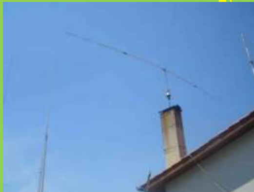
Antena dipolo rígido dos 40 mts no rotor. Total 8,30 mts.
